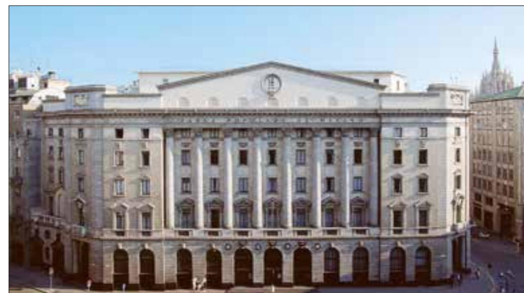
BPM: la sede centrale, in Piazza Meda a Milano
