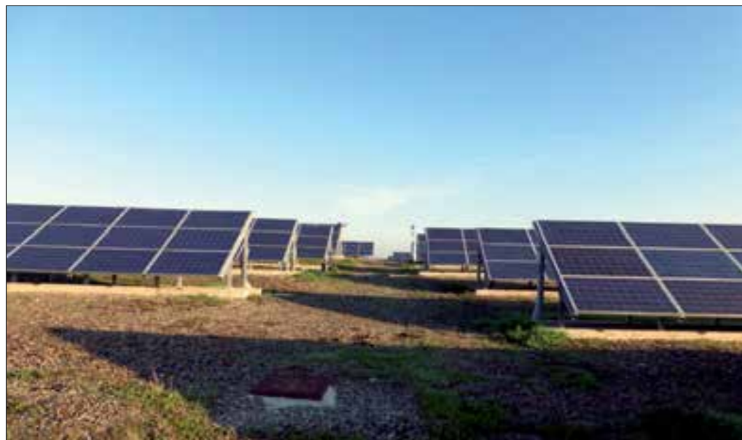
Il parco fotovoltaico di Castelceriolo
