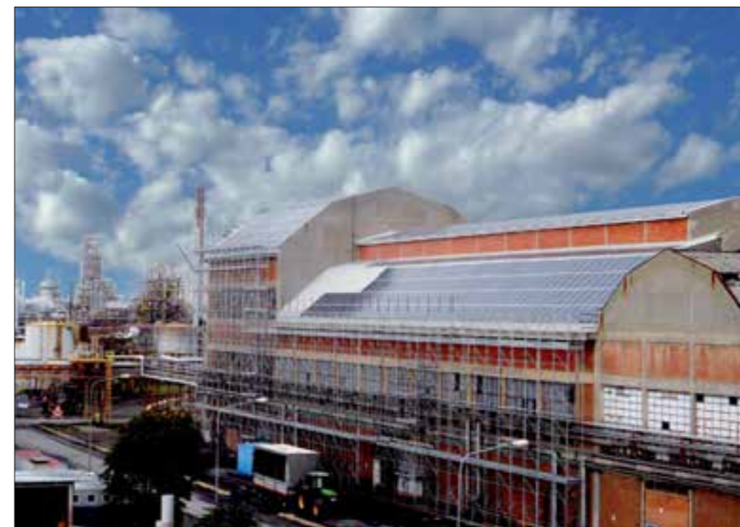
Campo Solvay: impianto fotovoltaico in corso di realizzazione
