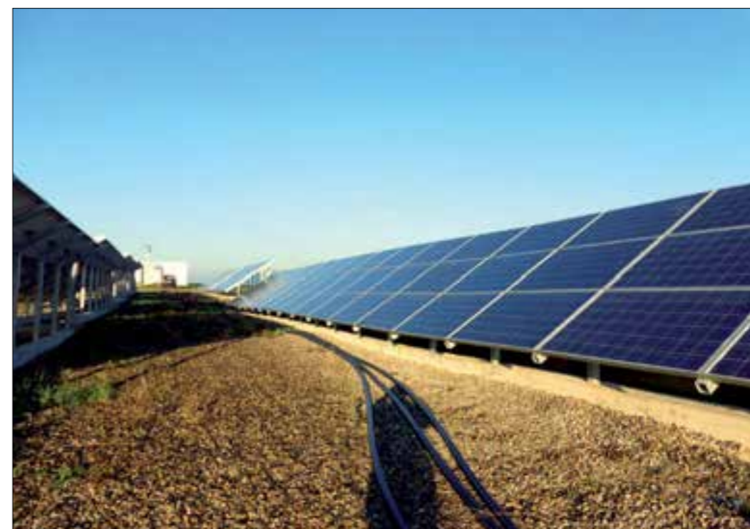
Il parco fotovoltaico di Castelceriolo
