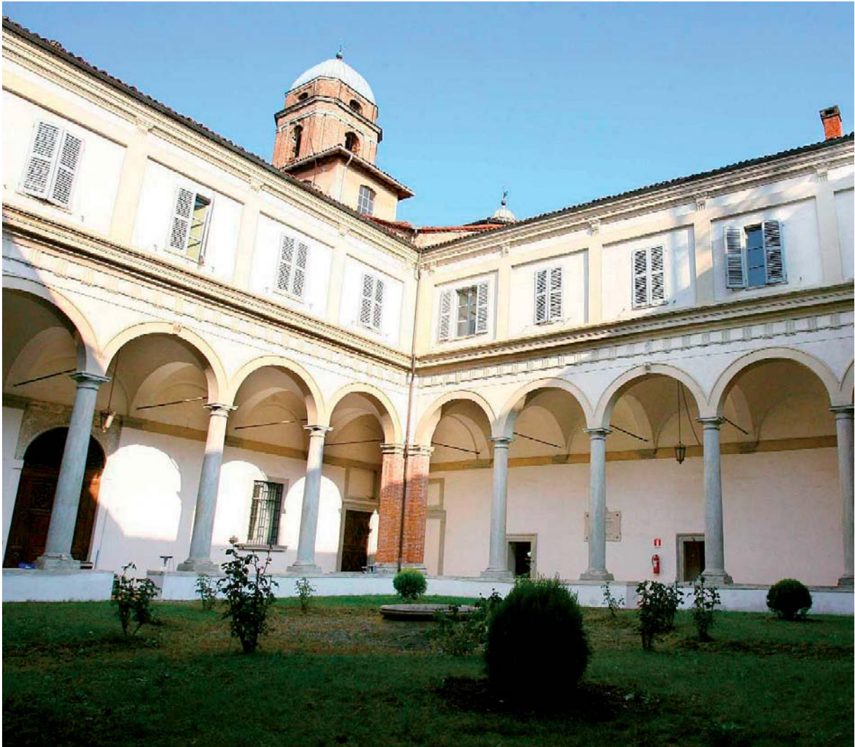
Veduta del chiosstro
